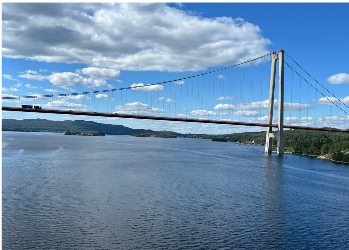
Fartyget vek av mot styrbord (höger) strax innan det var framme vid bron. Anledningen är att bronns segelfria höjd är 40 meter medan vårt fartyg är 42 meter högt.
